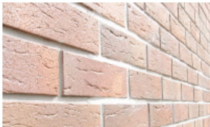
Наружная отделка зданий
